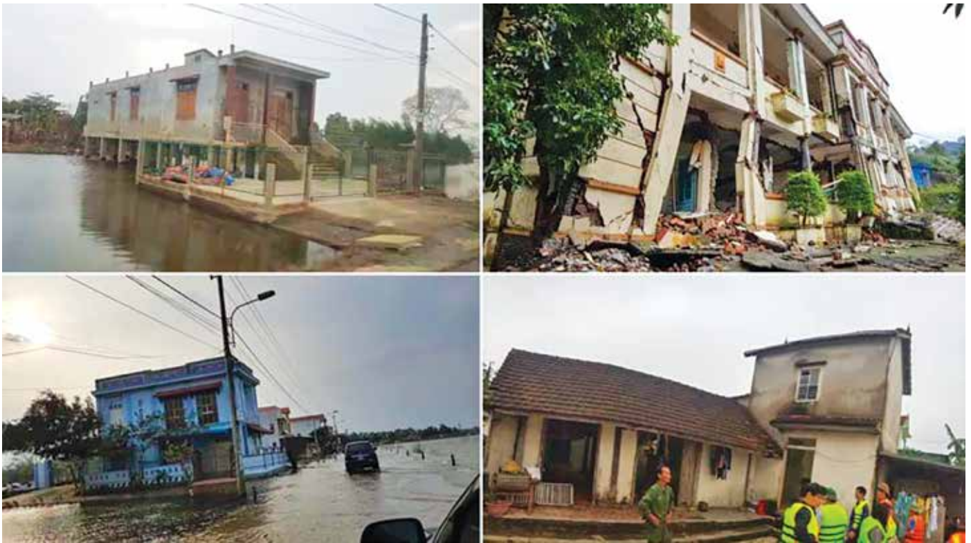
Một số hình ảnh về nhà ở và công trình công cộng bị phá hủy và ngập lụt tại miền Trung do cơn bão số 9 năm 2020 (Đoàn công tác khảo sát của Bộ Xây dựng).
