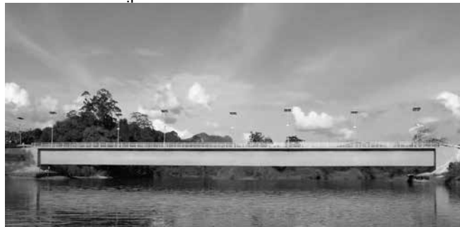
Hình 1. Cầu Batu 6 UHPC - nhịp 100m
