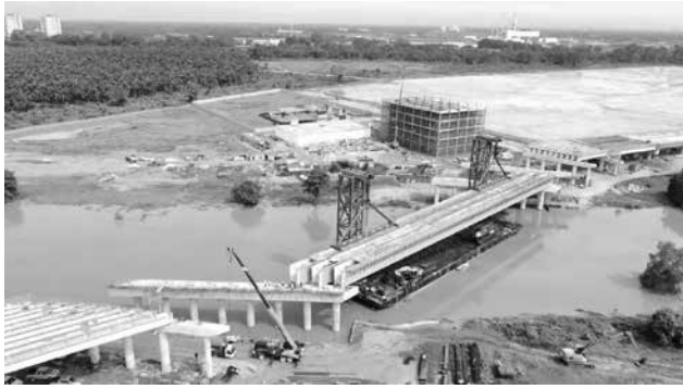
Hình 2. Cầu Sungai Langat UHPC - nhịp 105m. Kỷ lục thế giới với dầm UHPC, 2022.
