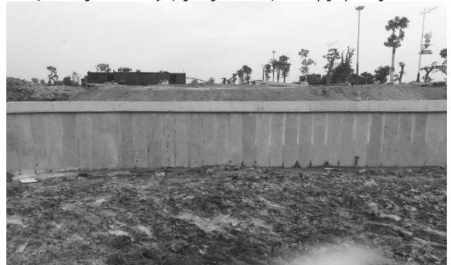
Bể xử lý sử dụng cử UHPC kết hợp cọc neo
